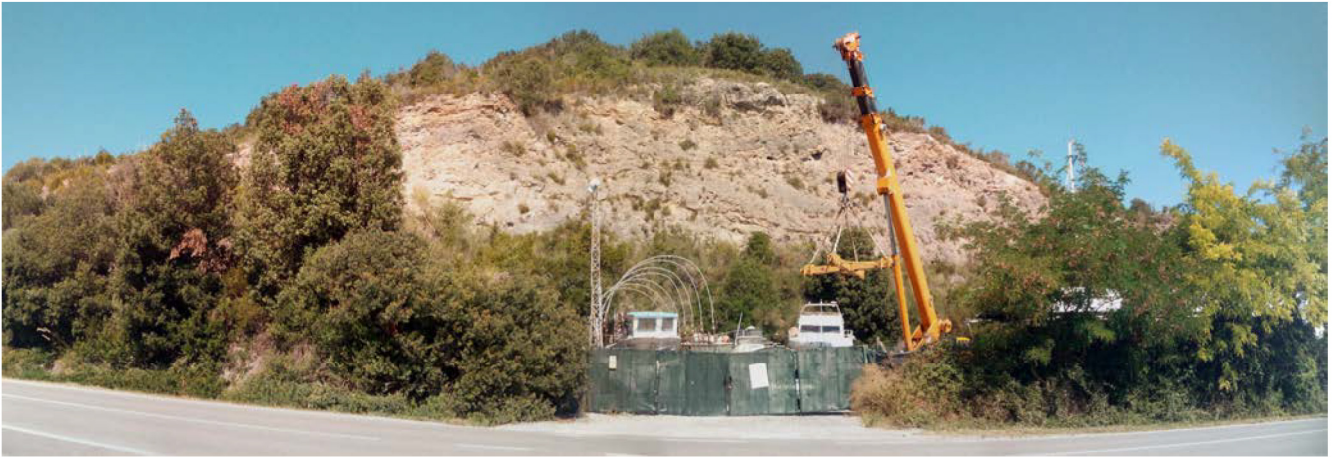
Foto 6 Panoramica della zona dell'ex cava (vista dalla strada provinciale)
