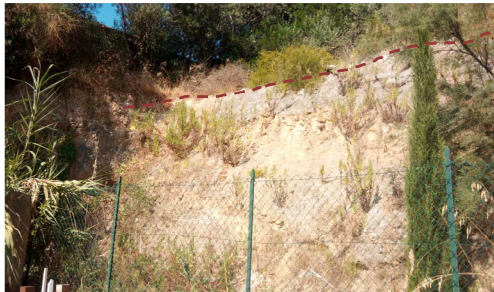
Foto 4 scarpata dietro cimitero. Visibile il calcare cavernoso e l'esiguo spessore di copertura.
