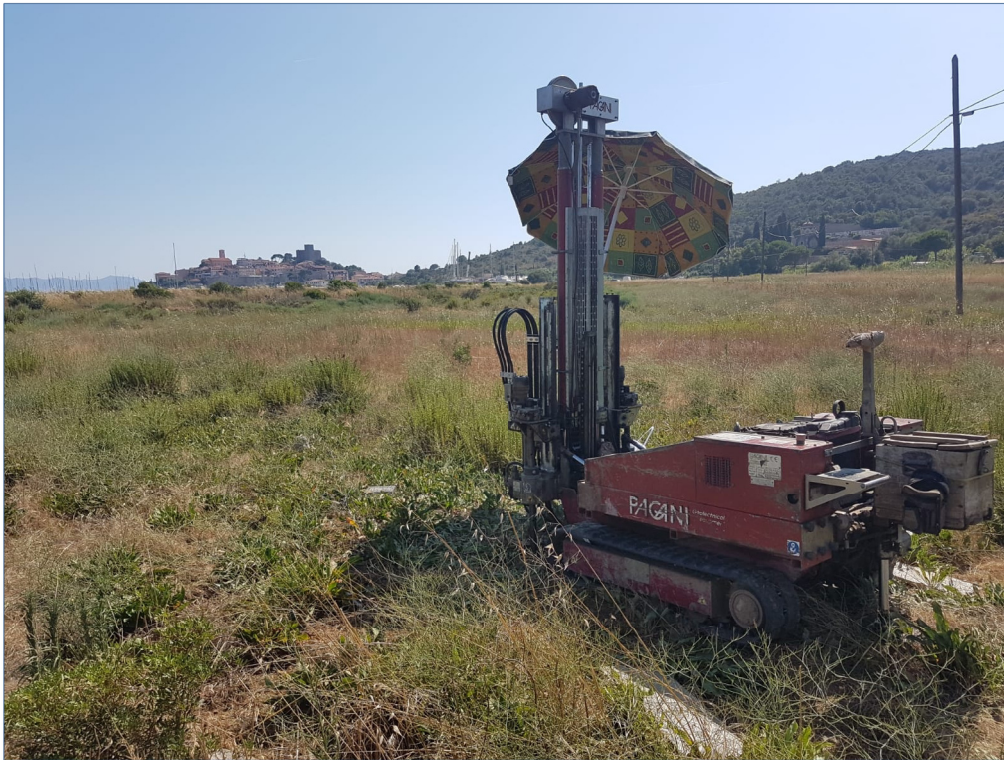
Figura 3: Prova penetrometrica CPT 3
