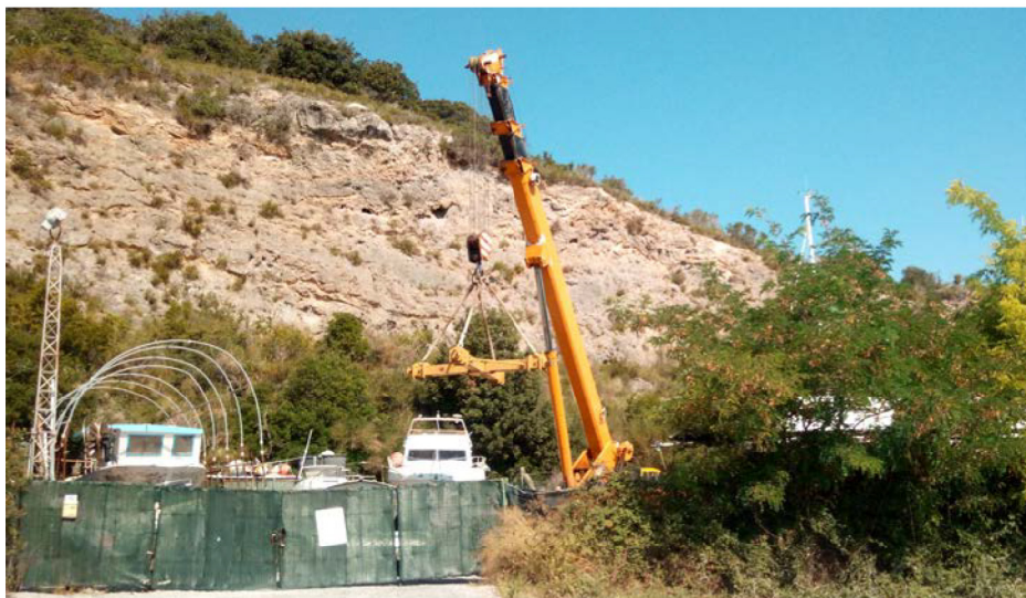
Foto 8 Panoramica della zona del piazzale, col deposito detritico vegetato alle spalle e la ex parete di scavo (vista da strada provinciale)
